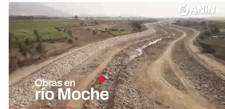
RÍO MOCHE 17 Km de enrocado
