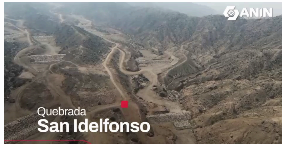
QUEBRADA SAN IDELFONSO 35 diques enrocados
