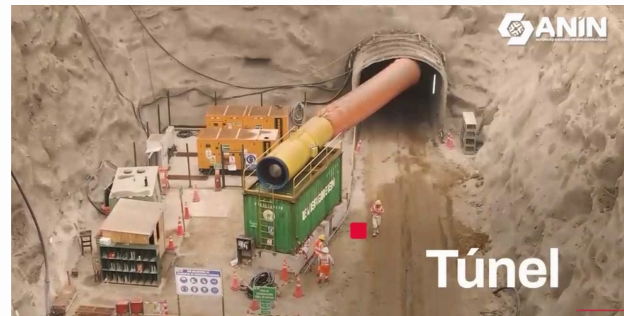
Túnel Tunel de desvio de agua
